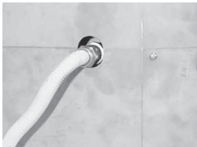
Raccord souple redirigé à l'aide d'un coude
