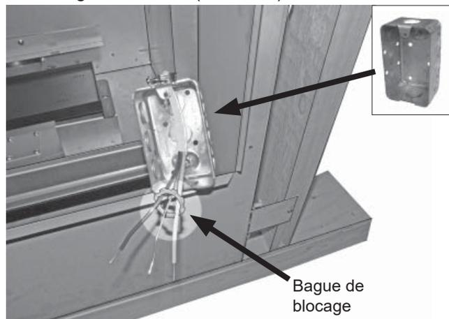
3. Enlevez la gaine des fils et raccordez-les à la prise de courant mise à la terre. Fractionnez la prise de courant pour deux contrôles séparés si le ventilateur et l'éclairage sont installés.
