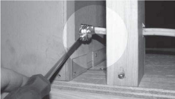
8. Serrez le serre-fil à l'extérieur de l'appareil et fixez l'excès de câble à la charpente.
