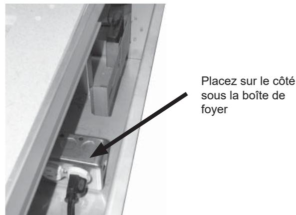
7. Tirez l'excès de câble vers l'extérieur à travers le serre-fil et serrez la bague de blocage au serre-fil. Un serre-fil sans bague de blocage peut être utilisé—assurez-vous que le serre-fil est approprié pour le type de câble utilisé.
