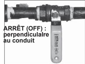
ARRÊT (OFF) : perpendiculaire au conduit
