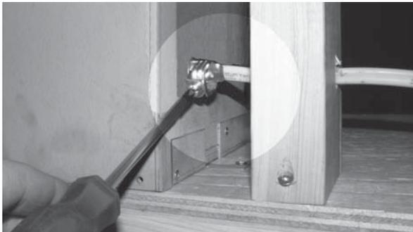
8. Serrez le serre-fil à l'extérieur de l'appareil et fixez l'excès de câble à la charpente.
