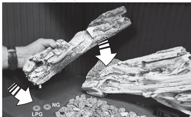
4. Placez la bûche de croisement gauche sur la bûche gauche et posez son bout recourbé sur le lit de gravier. Enlevez quelques morceaux de gravier de façon à ce que le bout soit sur la plateforme. Ajustez la position du bout recourbé selon le type de gaz utilisé.
