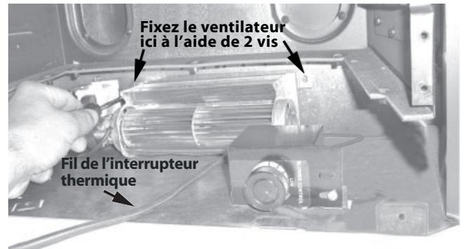
5. Enlevez le support de renforcement de la caisse extérieure du foyer (2 vis). Fixez l'interrupteur thermique au côté gauche de la boîte de foyer avec deux vis fournies.
