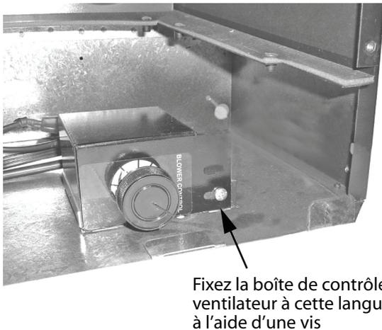
3. Faites passer le cordon d'alimentation dans l'ouverture du coin arrière gauche de la boîte de foyer. Ramenez le cordon d'alimentation et le fil de mise-à-terre de façon à ce qu'ils soient placés derrière le ventilateur lorsque celui-ci sera installé.
