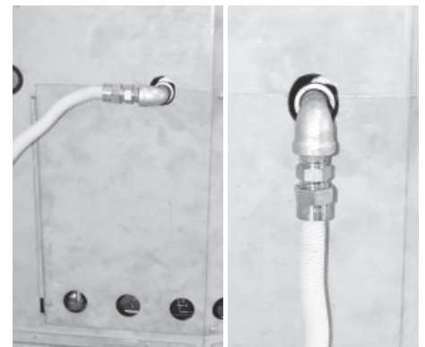
Raccord souple redirigé à l'aide de deux coudes
