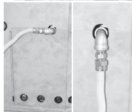
Raccord souple redirigé à l'aide de deux coudes
