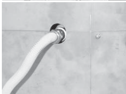
Raccord souple redirigé à l'aide d'un coude
