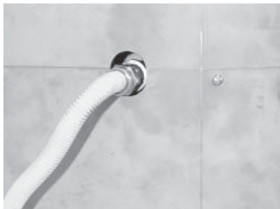
Raccord souple redirigé à l'aide d'un coude
