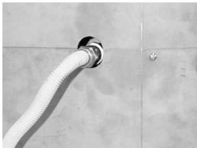
Raccord souple redirigé à l'aide d'un coude
