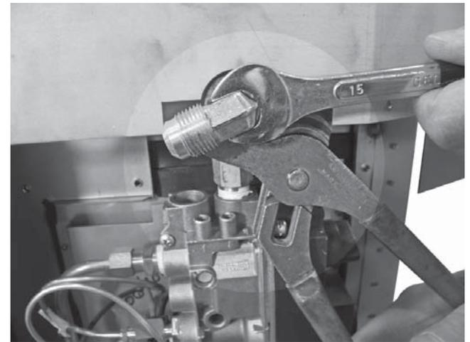
4. Installez la conduite souple au raccord coudé.
