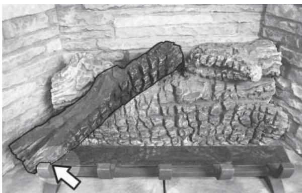
4. Placez la bûche avant droite tel qu'indiqué ci-dessous. Son bout gauche repose à plat sur la vitre. L'entaille doit être placée sur le deuxième montant de droite du porte-bûches. Le bout droit repose contre le montant de droite du porte-bûches.
