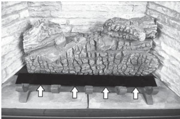
3. Identifiez la bûche gauche et placez-la sur la cheville sur la bûche arrière tel qu'indiqué. Le bout le plus large repose sur la vitre et devrait toucher le porte-bûches afin de permettre le passage des flammes par derrière.
