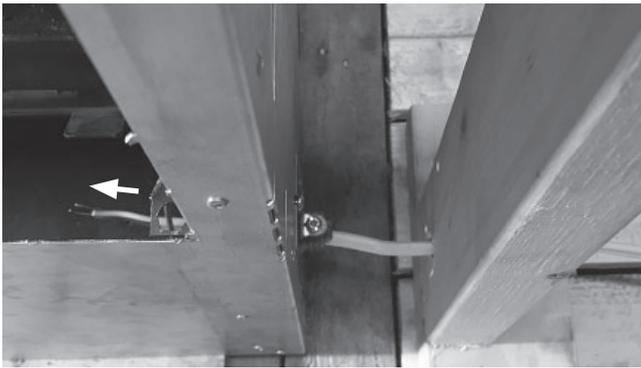
5. Enlevez la gaine des fils et raccordez-les à la prise de courant mise à la terre; terminez les fils avec des capuchons de connexion (non inclus).
