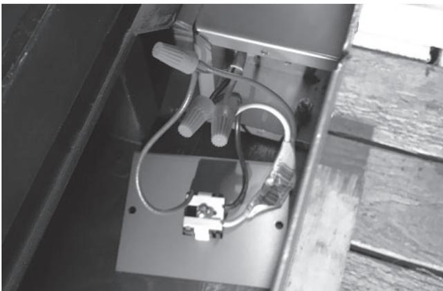
6. Remplacez la prise et le couvercle interne sur le boîtier et tirez l'excès de câble hors du foyer à travers le
