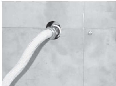
Raccord souple redirigé à l'aide d'un coude
